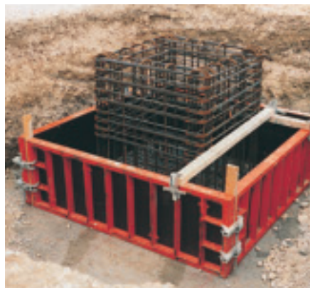
Применение элементов в лежачем положении при опалубливании фундаментов
