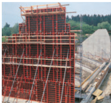
Стена высотой 13,20 м
