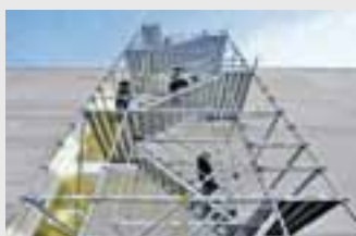
Лестницы, рабочие платформы
