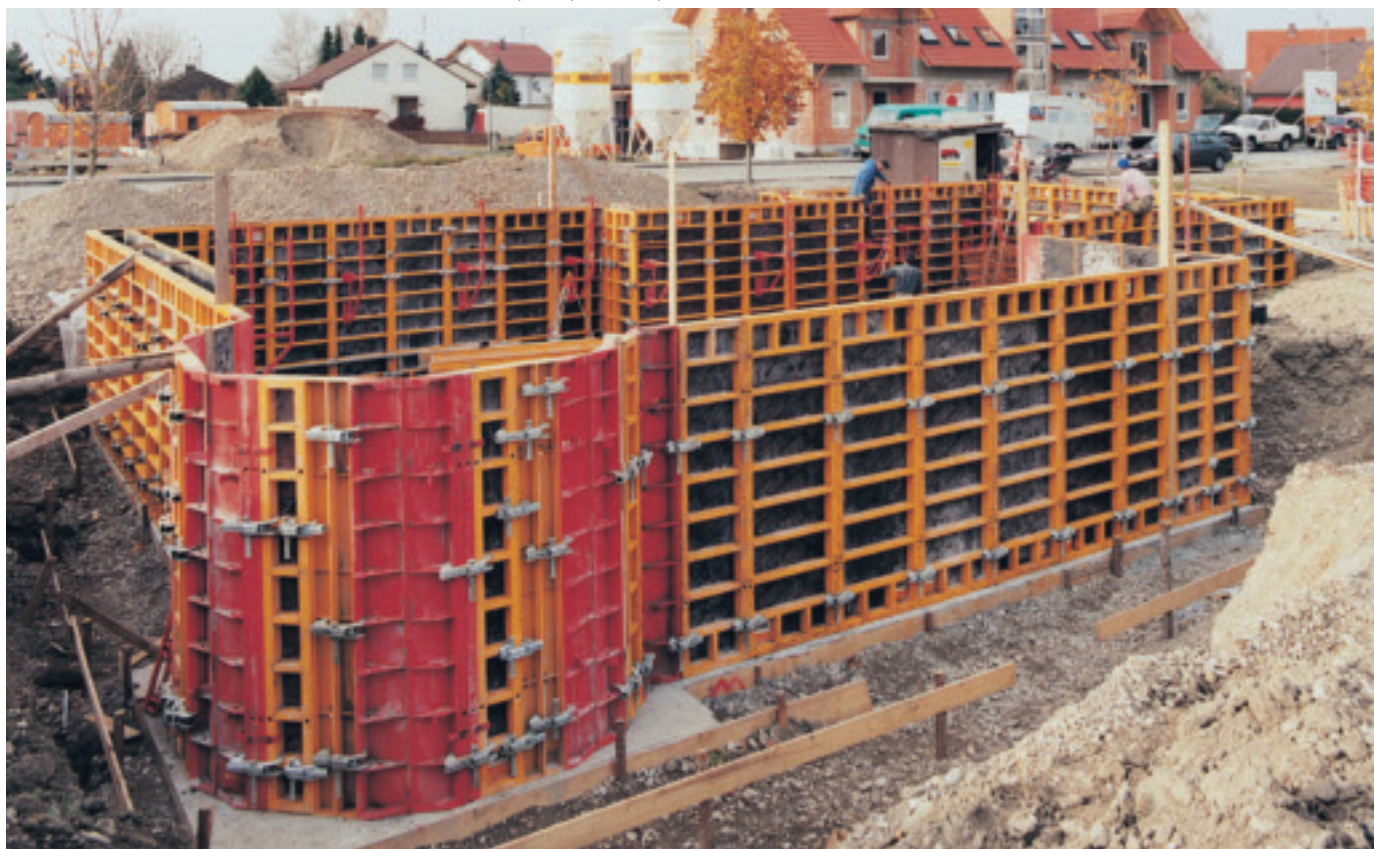
Элементы TRIO-L предлагаются в двух высотах (270 см и 90 см) и в четырех типоразмерах по ширине.
