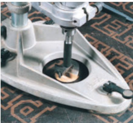
Посредством фанерных пластинок диаметром 60 мм возможен ремонт и более значительных повреждений.
