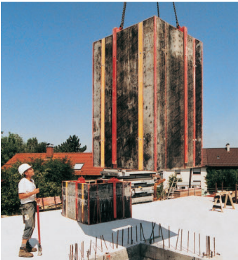
Опалубка шахты, целиком подвешенная на кране.
