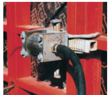
Присоединение наружного вибратора
