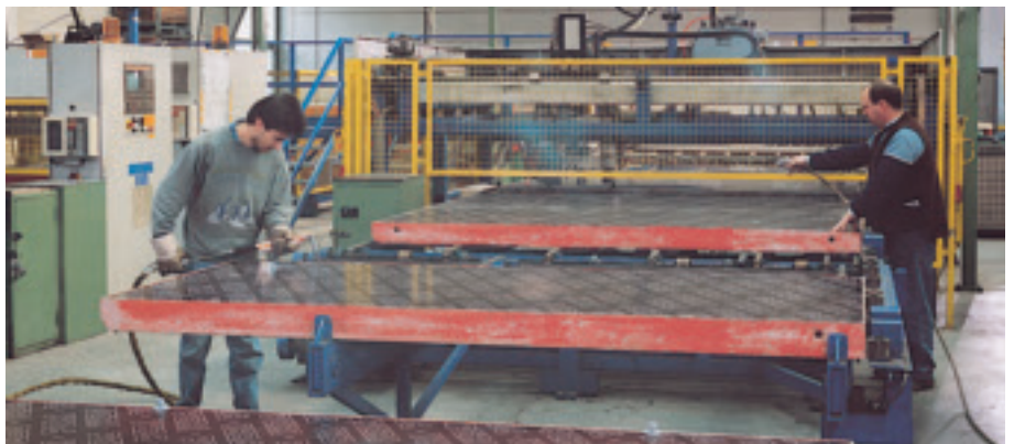
С помощью специального устройства новая фанера точно вставляется в очищенную раму и крепится заклепками. Шов по краям фанеры закрывается силиконом.
