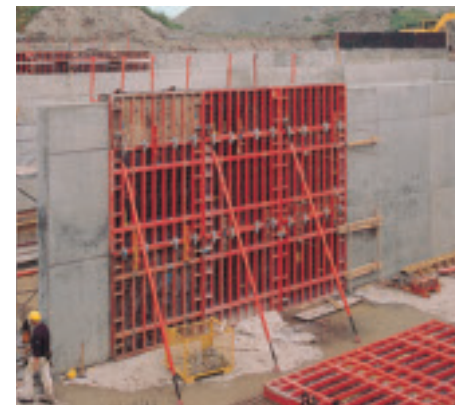
Элементы TRIO лежат с наращиванием до высоты 6,0 м
