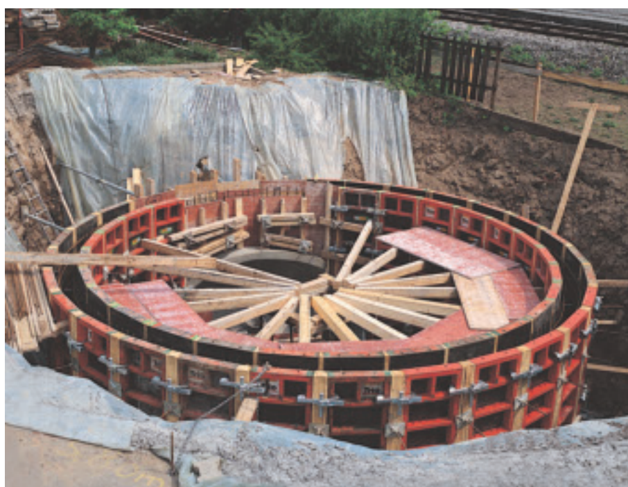
Канализационное сооружение - опалубка смонтирована из элементов TRIO TR 270 x 60.
