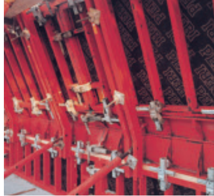
TRIO для наклонной крыши Угол осевого изгиба образуется шарнирным углом и нестандартным ригелем. Вертикальные усилия передаются через ригели и подкосы.
