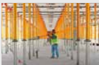
Опалубка для перекрытий
