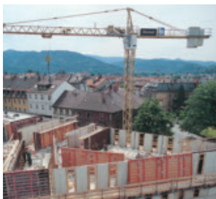
Монтажные единицы элементов шириной до 9 м и высотой 2,70 м с крупногабаритной фанерой.
