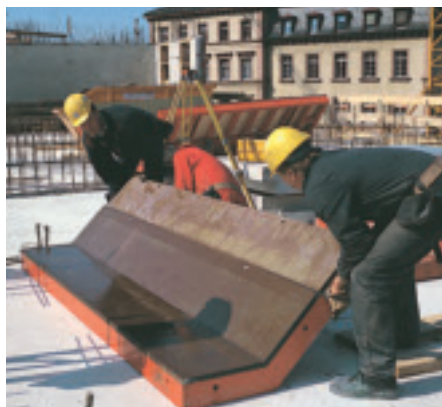
Строительство гостиницы: угловой элемент 135° с крупногабаритной облицовочной фанерой.
