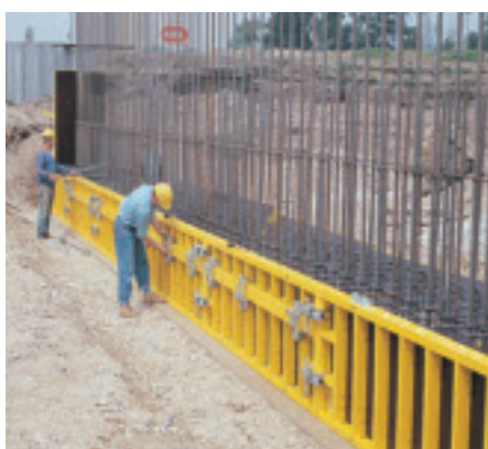
TRIO-L при опалубке фундаментов.
